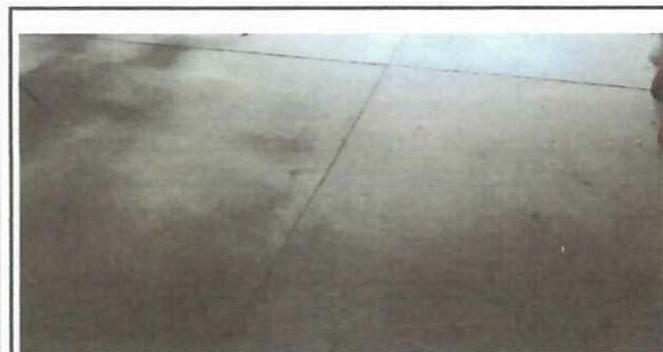
Foto: 5 CAMBIO DE PISO A CERÁMICO Los pisos de torta son inherentemente porosos, se desgastan rápidamente, acumulan polvo y suciedad en sus irregularidades.
